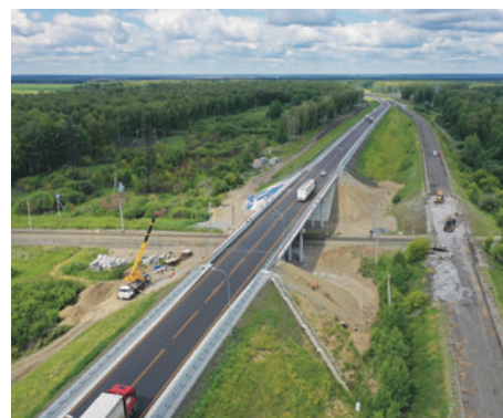
Автомобильная дорога Р-255 «Сибирь», км 152 + 300
