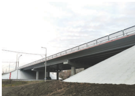
Ремонт путепровода через автодорогу на км 821 + 400 автодороги Р-254 «Иртыш», Омская область
