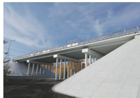
Ремонт путепровода через железную дорогу на км 781 + 607 автодороги Р-254 «Иртыш», Омская область
