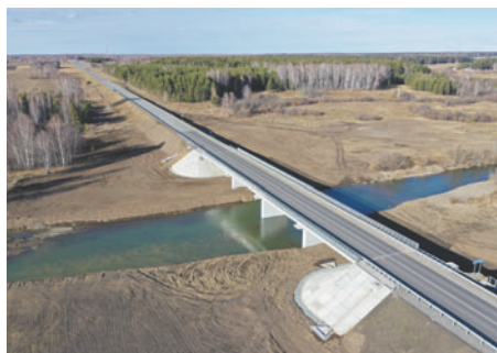
Капитальный ремонт моста через реку Лебяжья на км 41 + 028 автодороги Р-255 «Сибирь», подъезд к городу Томску, Кемеровская область
