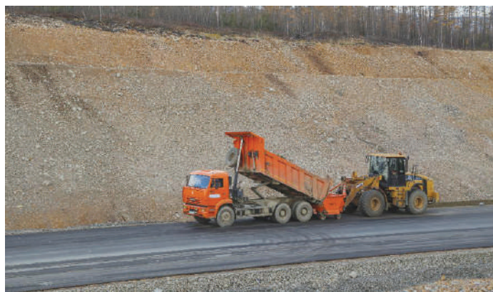
Реконструкция автодороги А-360 «Лена» Невер – Якутск
