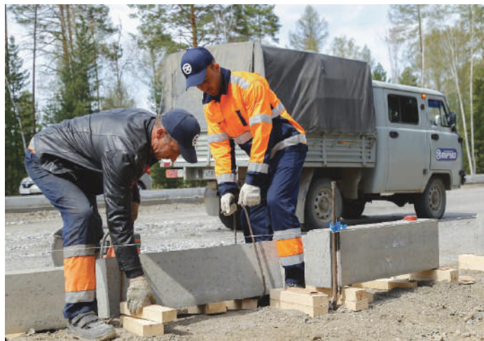
Участок строительства км 47 – км 55 автодороги Р-258 «Байкал»
