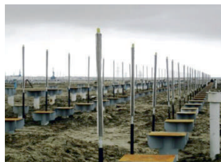
Термостабилизаторы грунта
